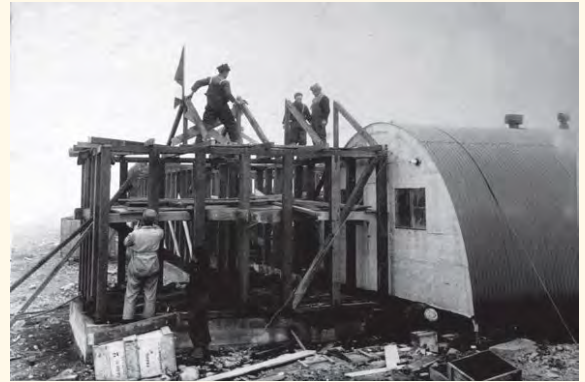
Construcción de base Soberanía, hoy base naval Arturo Prat.
