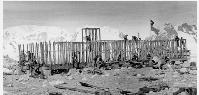
Faenas de construcción de la base original
